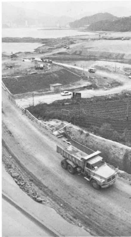
大埔工業邨首批地盤四月竣工
